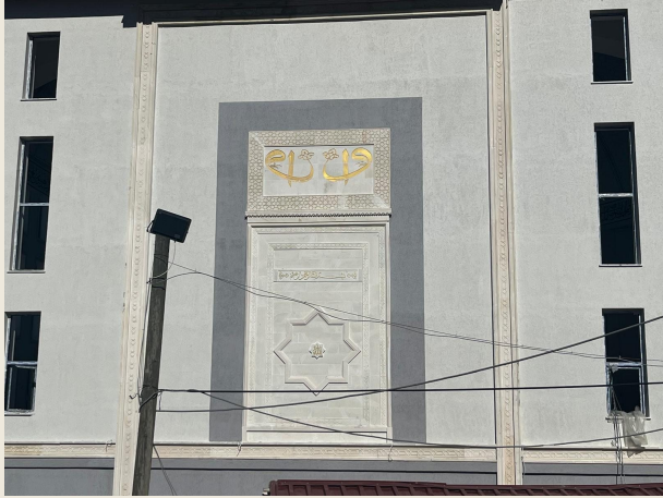
49 Cephe ve yapı uygulamaları · 15
