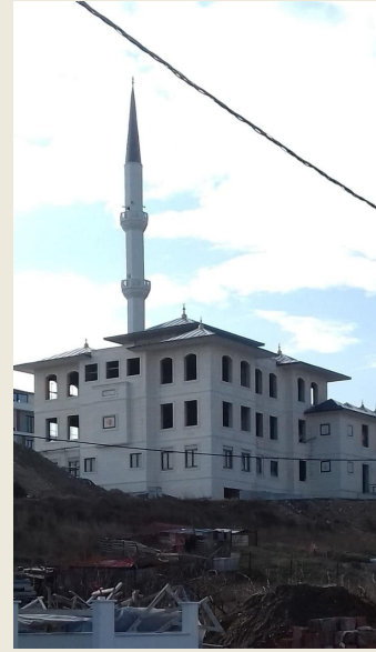
50 Cephe ve yapı uygulamaları · 16
