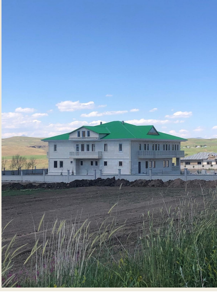
47 Cephe ve yapı uygulamaları · 13
