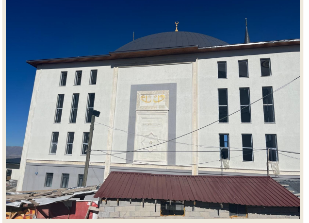
48 Cephe ve yapı uygulamaları · 14
