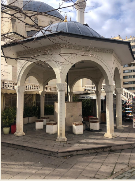
45 Cephe ve yapı uygulamaları · 11
