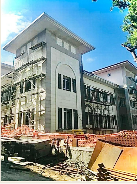
43 Cephe ve yapı uygulamaları · 09
